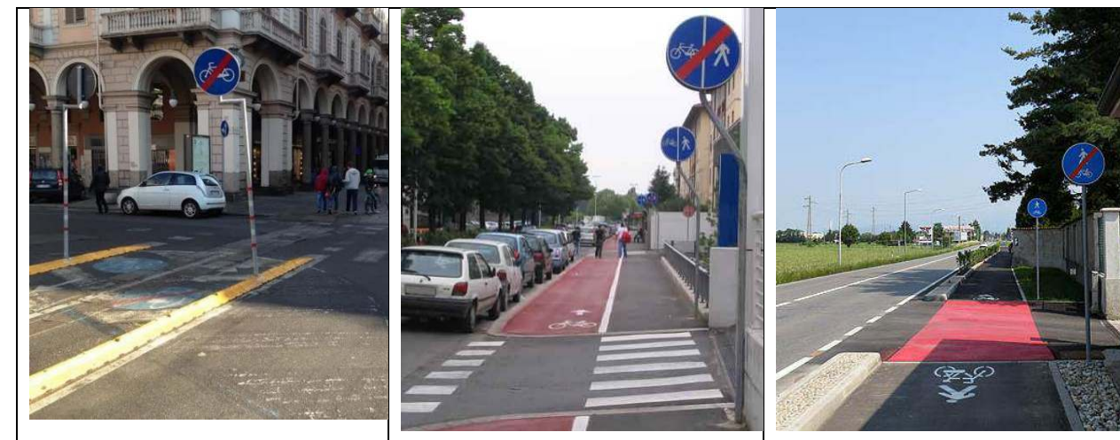
FIGURA 78 UTILIZZO IMPROPRIO DEL CARTELLO "FINE PISTA CICLABILE" IN CORRISPONDENZA DI ATTRAVERSAMENTI CICLABILI O CICLOPEDONALI
