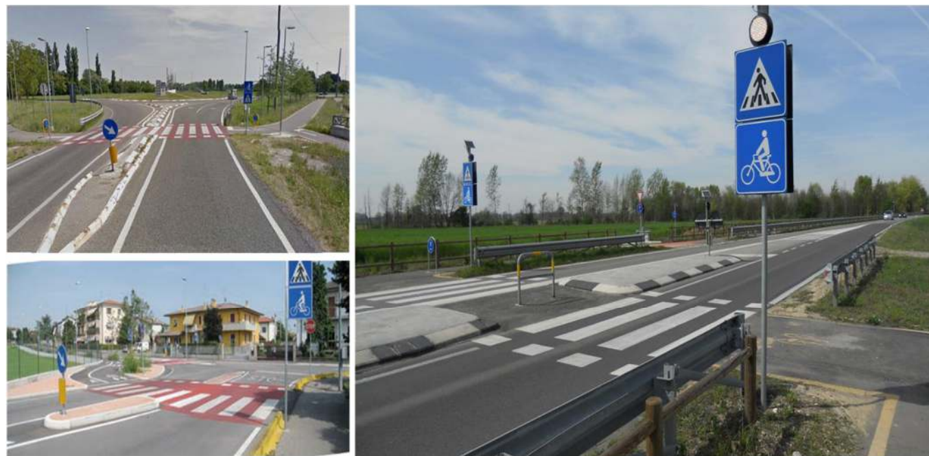
FIGURA 77 ATTRAVERSAMENTO CON ISOLA CENTRALE SALVAGENTE (LA PRESENZA DI ARCHETTI E PALETTI IN CORRISPONDENZA E OLTRE L'ATTRAVERSAMENTO RAPPRESENTA UN ELEMENTO DI PERICOLOSITÀ E DIFFICOLTÀ DI PASSAGGIO PER I MEZZI PIÙ INGOMBRANTI COME BICI CON CARRELLO, TANDEM ETC.)
