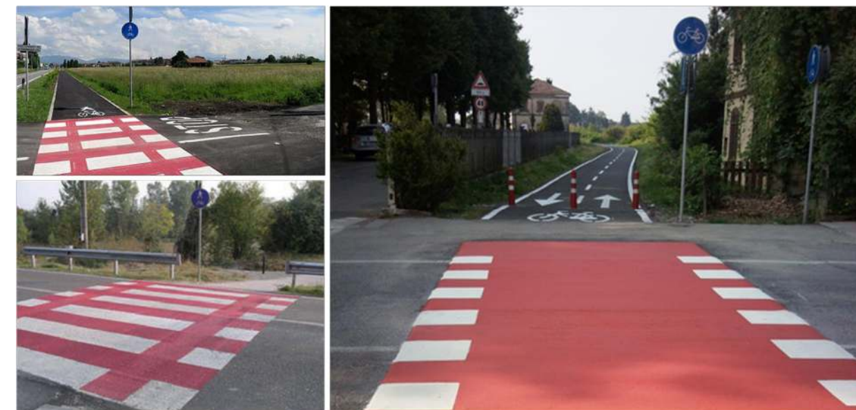
FIGURA 76 ATTRAVERSAMENTO CICLABILE SEMPLICE (LA PRESENZA DI ARCHETTI E PALETTI OLTRE L'ATTRAVERSAMENTO RAPPRESENTA UN ELEMENTO DI PERICOLOSITÀ E DIFFICOLTÀ DI PASSAGGIO PER I MEZZI PIÙ INGOMBRANTI COME BICI CON CARRELLO, TANDEM ETC.)
